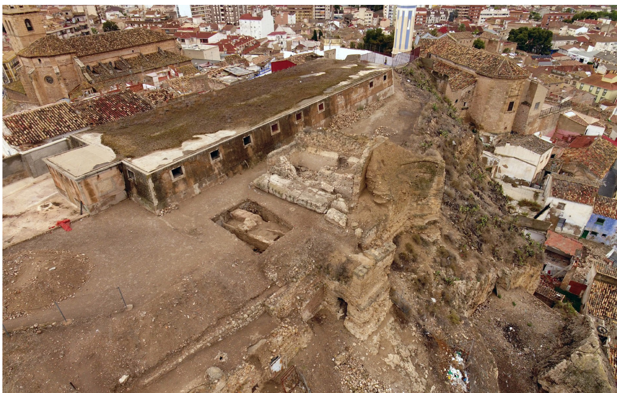
Figura 1. Vista área del sector noreste del Castillo, con dos de los sondeos realizados en 2023.
