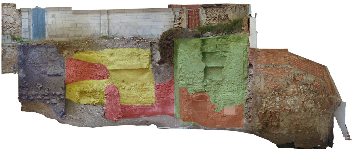
Figura 11. Ortofoto interpretada del alzado este de la muralla. Azul: Torre UEC 4002. Verde: Torre UEC 4001. Amarillo: Muralla en tapia (UM 4003-04). Rojo: Reformas o añadidos contemporáneos.
