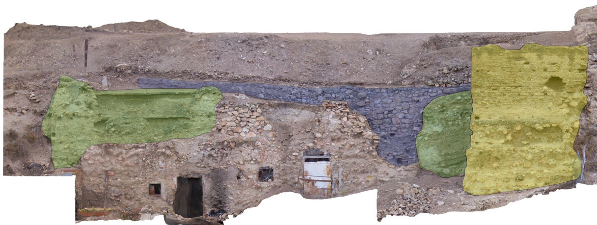
Figura 10. Ortofotografía frontal de la muralla oeste. Interpretada. Murallas en tapial (trama verde). Izquierda tapial calicostrado. UM 3002. Derecha tapial hormigonado. UM 3005. Muro en mampostería (trama azul). UM 3004. Torre calicostrada (Trama amarilla) UEC 3006).
