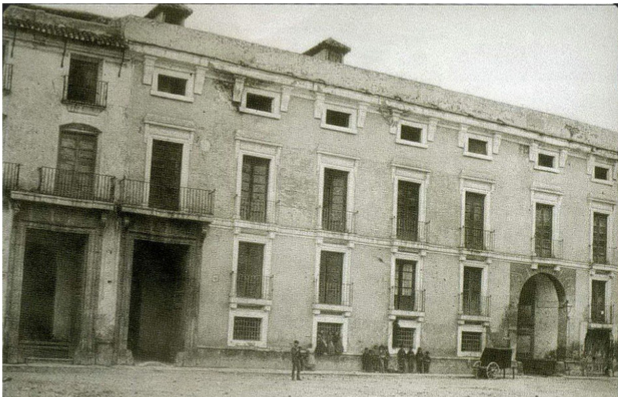
Figura 1. Casa - Palacio del Conde de Floridablanca. Murcia, 1872. Fotografía de Juan Almagro Roca (1837 – 1899).
