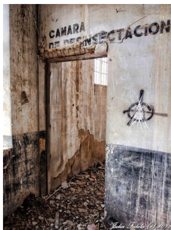
Cámara de desinsectación. Ruinas prisión de La Loma / Foto Julia Fatela
